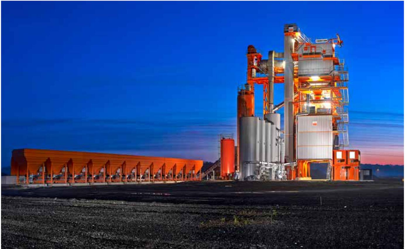
L'Universal HRT a été équipé d'un tambour sécheur parallèle, de 12 doseurs agrégats vierges et d'un stockage d'enrobés à chaud de 600 t en 6 compartiments.
