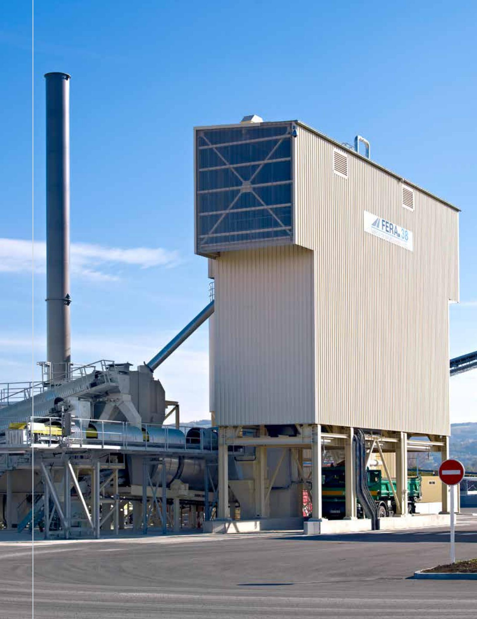
Photo en haut : Avant bardage de la tour de mélange – le ContiMix 120-320 a été équipé avec un tambour sécheur à recycler RAH100.
