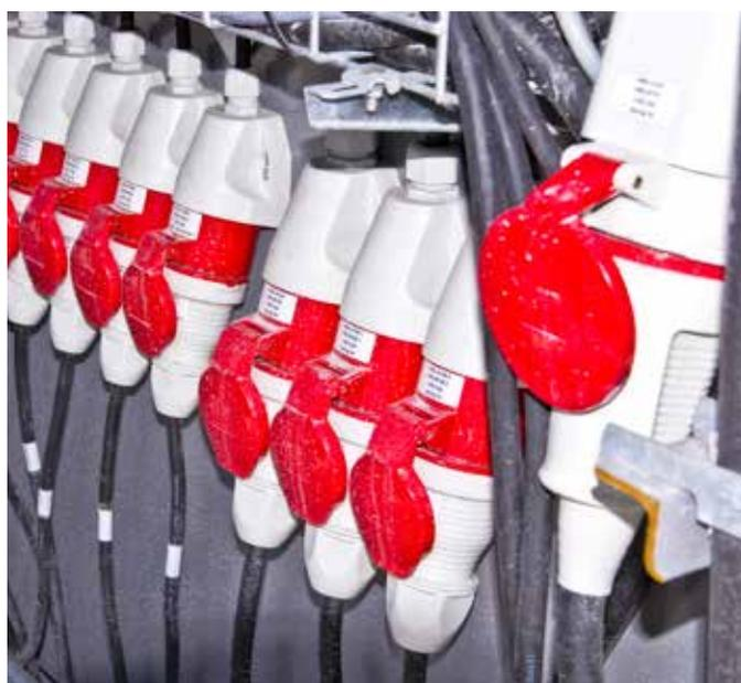
BlackMove II : connecteurs électriques enfichable pour les câbles principaux, ainsi aucun électricien n'est nécessaire
