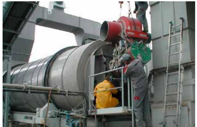
Mise en place d'un brûleur TAB. Les TAB sont des brûleurs permettant une poste combustion. Ces brûleurs aspirent les vapeurs de bitume provenant des casques de vidanges des trémies de stockage d'enrobés à chaud, et les brûle par poste combustion.
