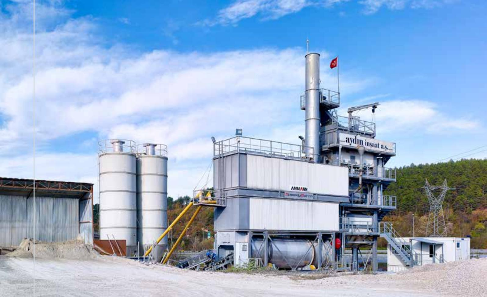
De nombreuses options sont possibles : Pour augmenter les capacités de chargement, la SpeedBatch peut être équipée d'une Trémie de chargement – déportée de 30 t ou de 112 t L'installation peut ainsi être équipée d'un recyclage à froid ou à chaud.
