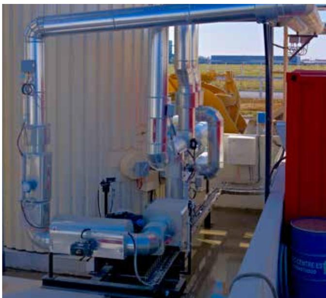
Dosage exact du bitume au moyen d'un débitmètre Coriolis.
