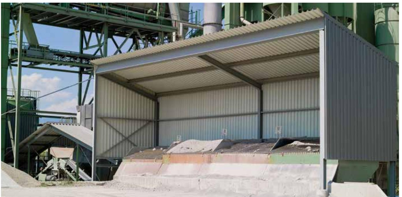
Mise à l'abri sous toiture du prédosage pour les matériaux de recyclage en guise de mesure efficace pour l'abaissement de la consommation de combustible.
