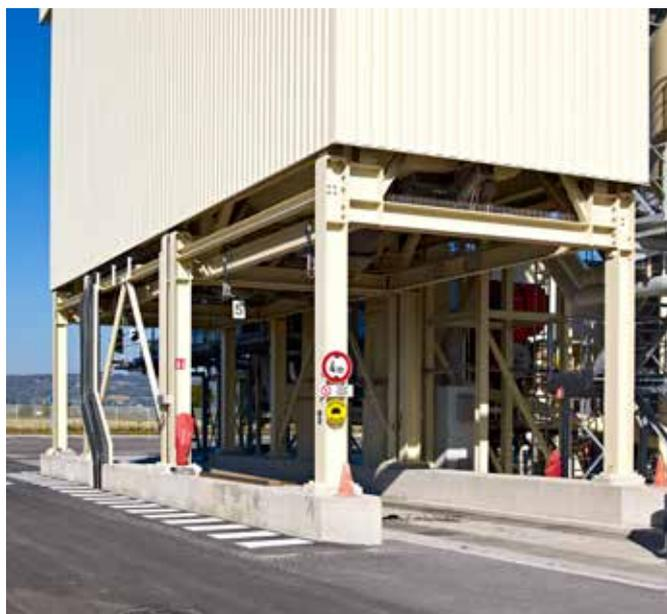
Trémie de chargement une voie avec sens de passage des camions dans la longueur.
