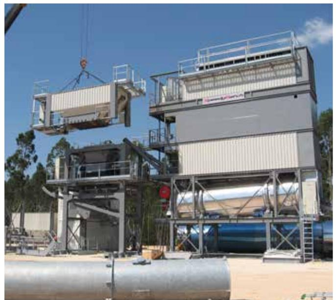
Un sol nivelé et compacté suffit pour installer une SpeedyBatch.
