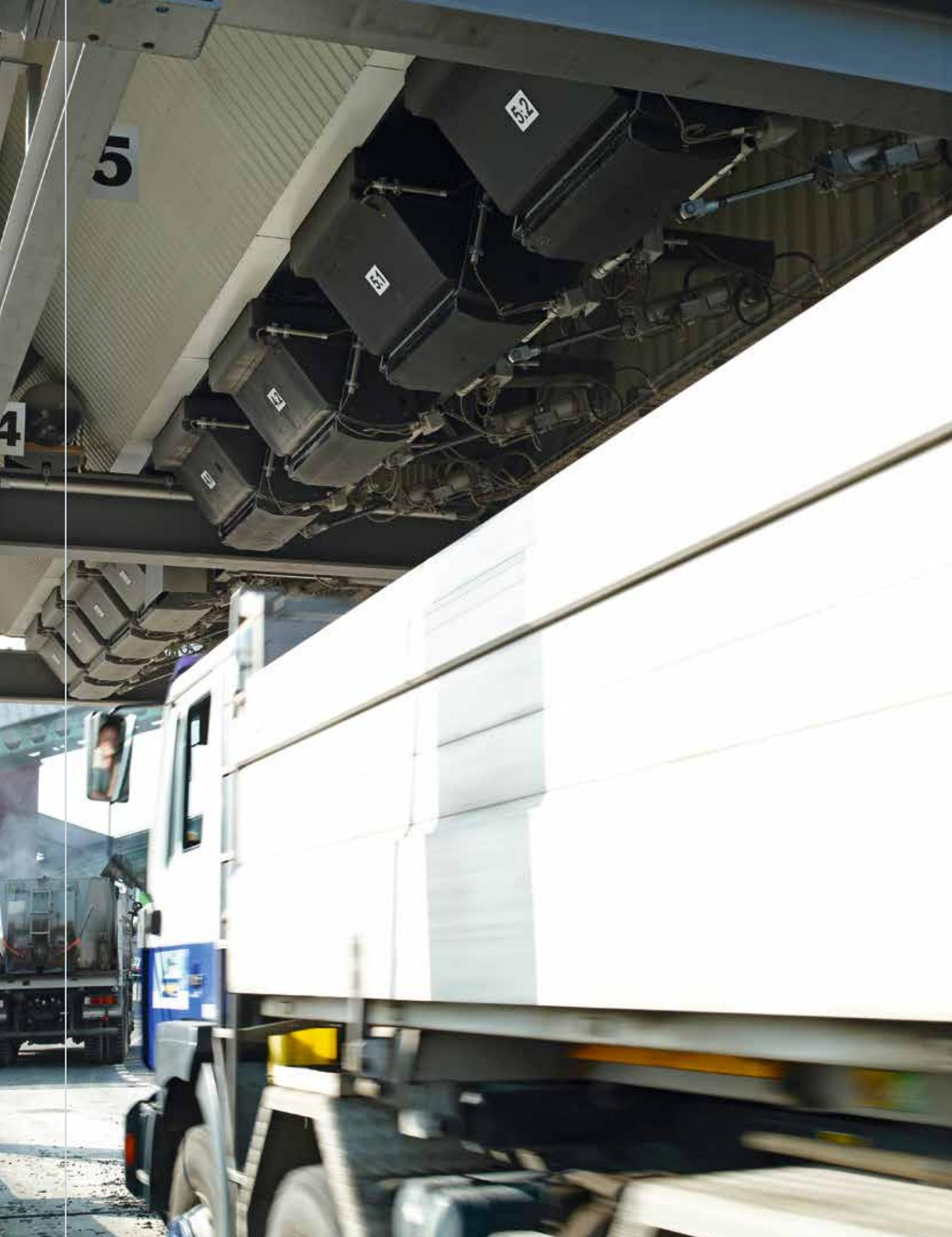
Silos de stockage d'enrobés à chaud avec clapets de vidange en ligne. Les Clapets de vidange sont aussi disponible avec une rotation de 90°.
