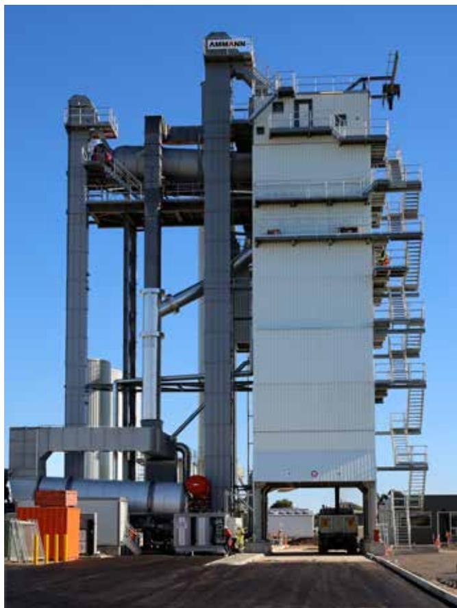
L'Universal HRT avec bardage complet de la tour de mélange, et équipé d'un tambour sécheur parallèle pour une injection de recycler jusqu'à 60%.
